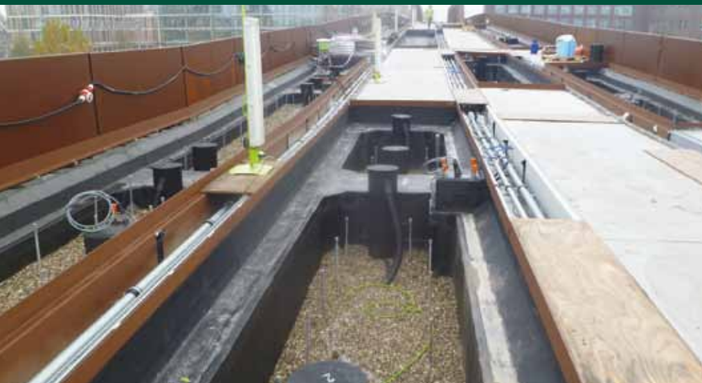
Opbouw boombak. Onderin een drainlaag van 10 cm grind met daarin een drainslang. Aan beginpunt een put om drainage door te spuiten. Aan eindpunt een put om de verbinding door het brugdek naar de andere boombak door te spuiten. De draadeinden voor de verankeringskorven steken omhoog. De groene kabel is voor de vochtsensor. De zwarte tyeenslang voor de druppelslang. In de kabelgoten zijn de leidingen voor de vloerverwarming zichtbaar.
